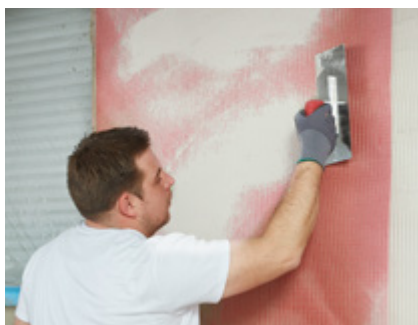
Dämmstoffe armieren
