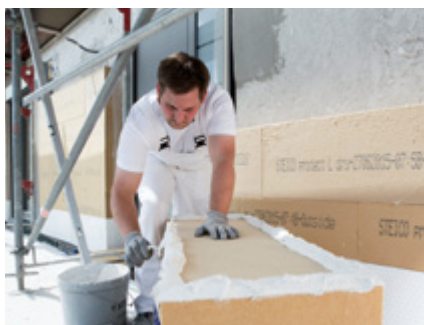
Dämmstoffe kleben
