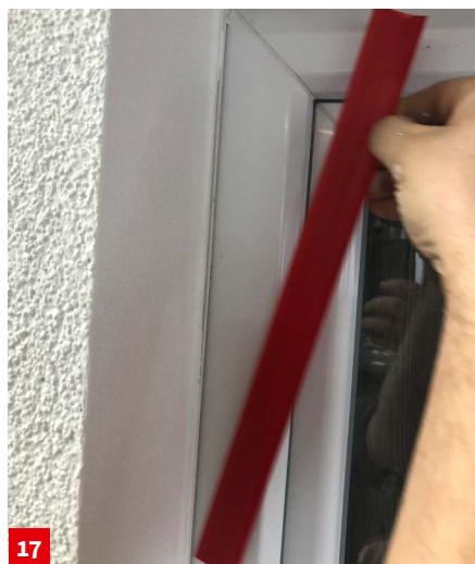
16 Schutzfolienentfernung und ggfls Aktivierung des Fensteranschlussprofils
