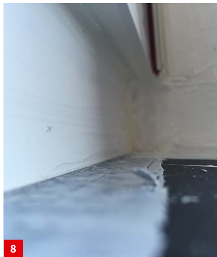
Verschließen und Abspachteln des Gewerke Loch mit akurit VARIO MK Montagekleber
